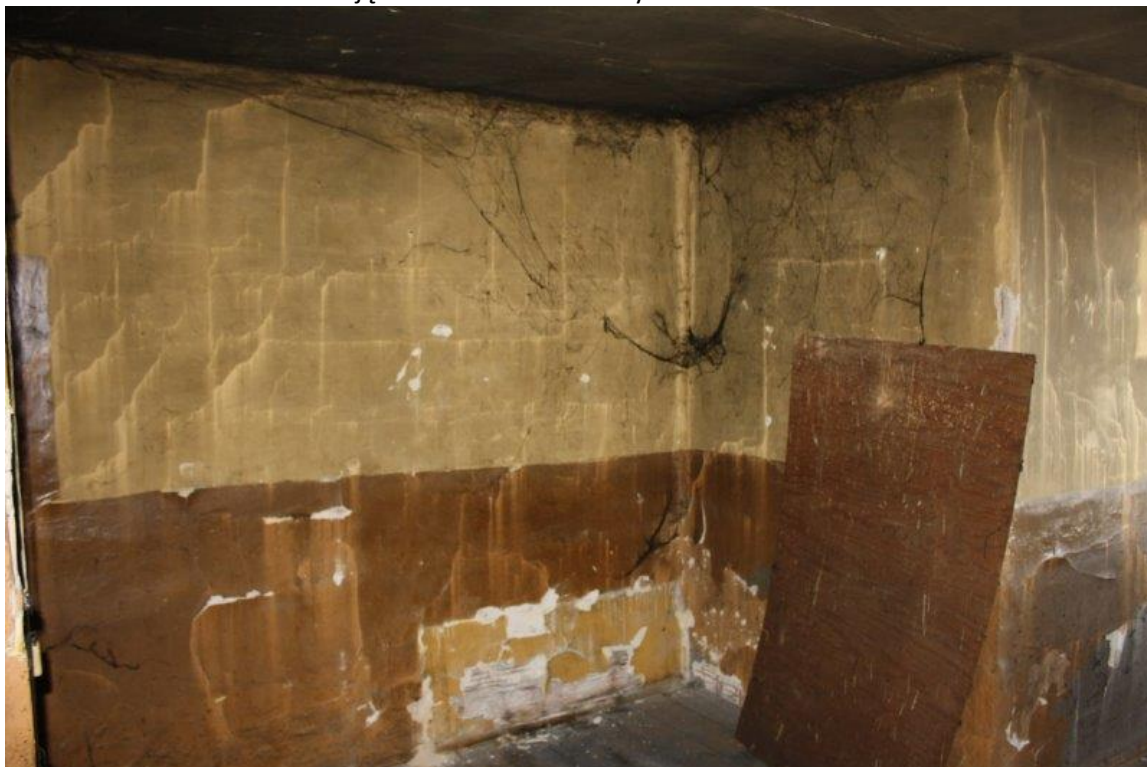
Zdjęcie 9 Poddasze w budynku w Klonowie
